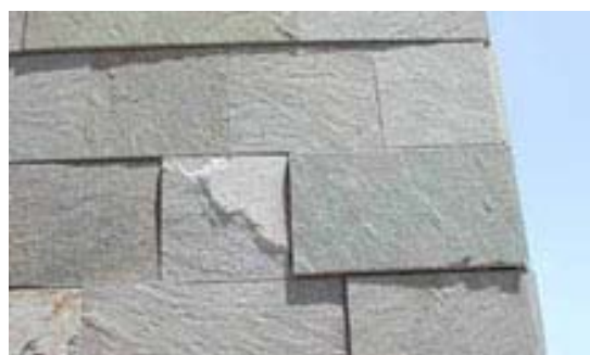
Dettaglio lastre in porfido
